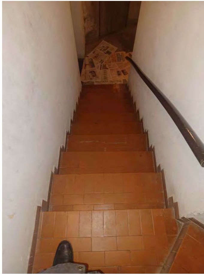
Scale di accesso alla cantina
