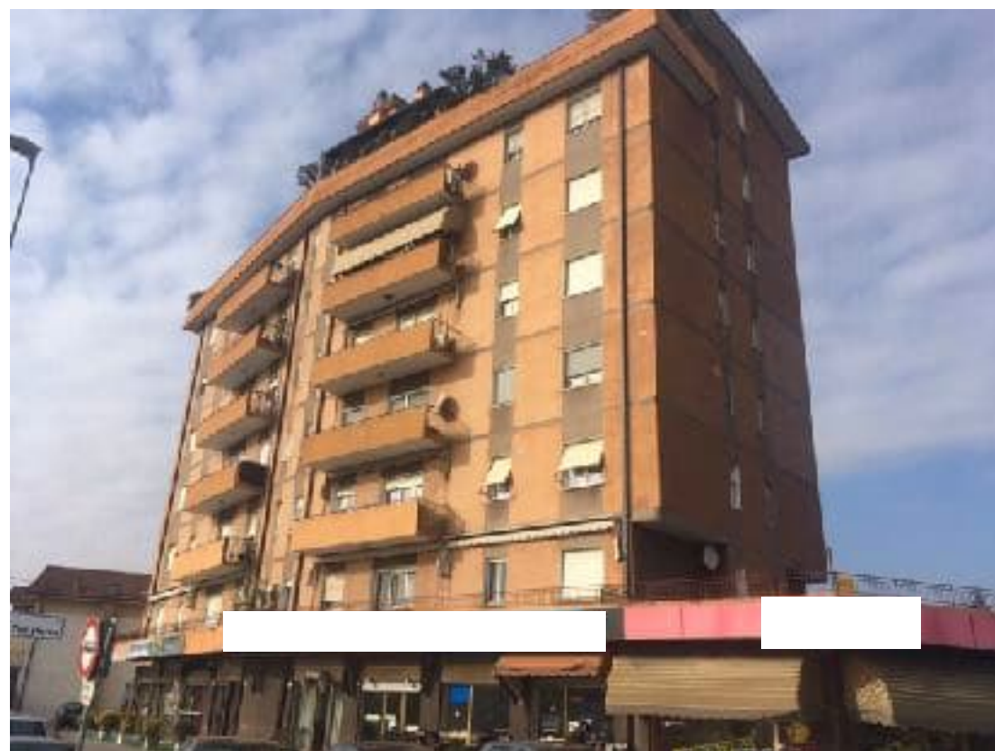
Vista esterna condominio Brentella
