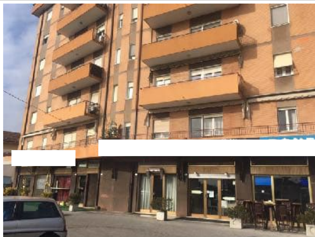
Vista piano terreno condominio Brentella
