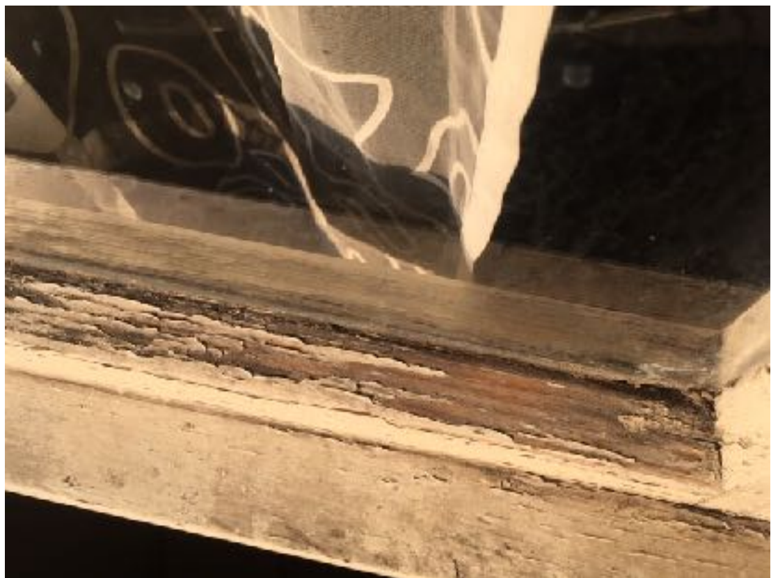
Particolare stato manutenzione serramenti esterni
