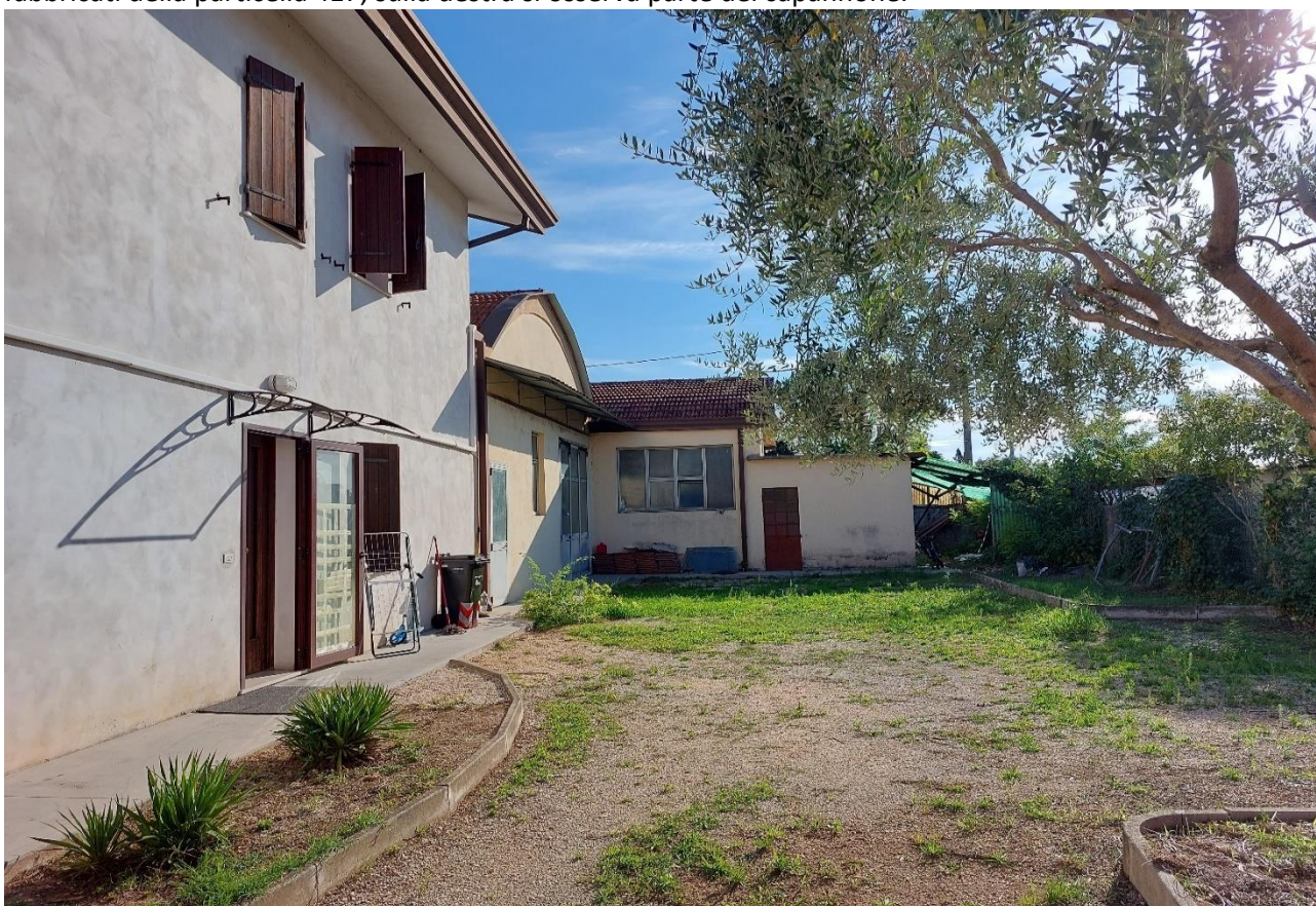
Lotto 1 - Comune di Pordenone (PN) – Frazione Rorai Grande – Via Conegliano n°4. Particolare dell'accesso carrabile ai fabbricati della particella 417 e dell'area comune, nella porzione sud della proprietà.
