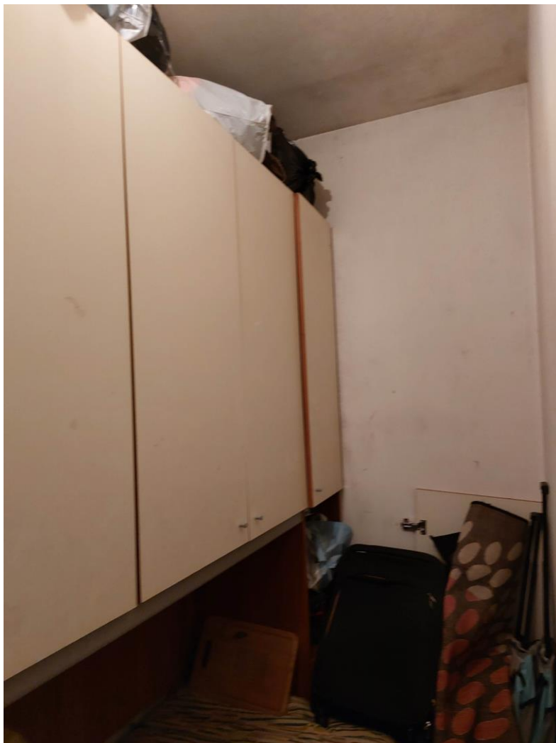
Foto n° 9 - Lotto 1 - 22/08/2022 - Comune di Pordenone - Foglio 11 - mappale 417 sub 2, appartamento A/4 - Veduta interna del ripostiglio adiacente alla cucina.
