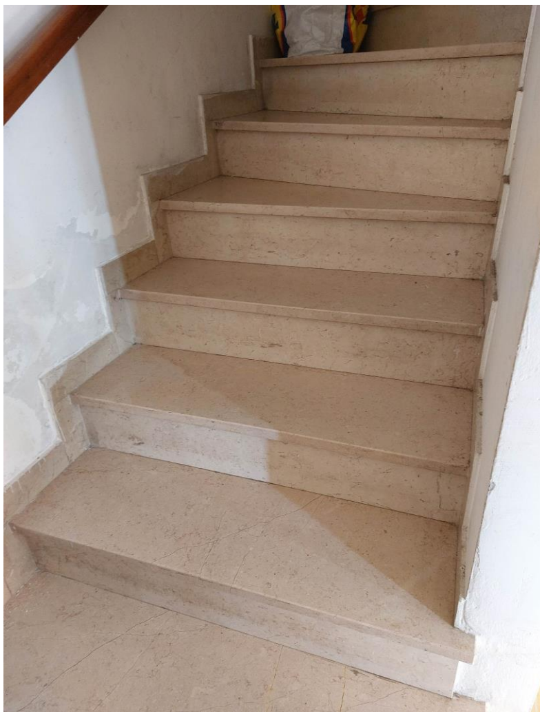
Foto n° 10 - Lotto 1 - 22/08/2022 - Comune di Pordenone - Foglio 11 - mappale 417 sub 2, appartamento A/4 - Veduta del vano scale da cui si accede al primo piano.
