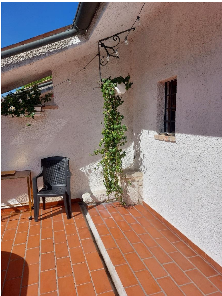
Foto n° 47 – Lotto 2 – 22/08/2022 - Comune di Porcia – Foglio 13 – mappale 700 sub 1 – Particolare del terrazzo esterno al primo piano, nella parte a nord-ovest.
