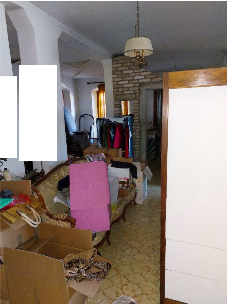
Foto n° 32 – Lotto 2 – 22/08/2022 - Comune di Porcia – Foglio 13 – mappale 700 sub 2 – Veduta, da posizione est, del secondo disimpegno, dal quale si accede ai quattro uffici e all'ingresso loro riservato, posto sul prospetto ovest dell'edificio.
