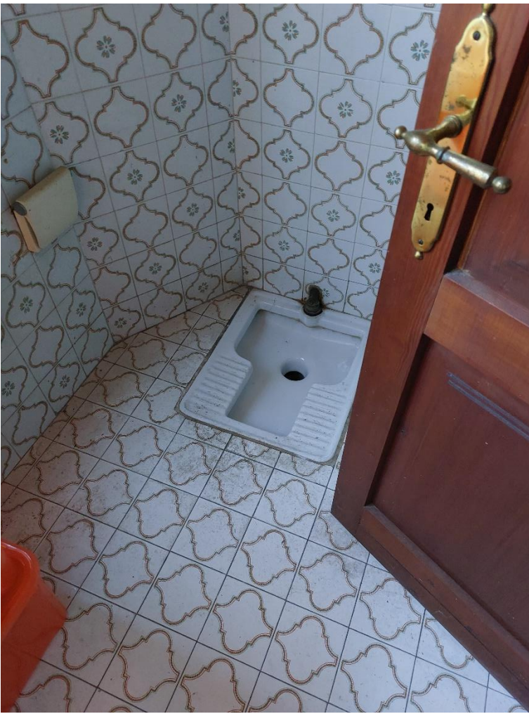
Foto n° 29 – Lotto 2 – 22/08/2022 - Comune di Porcia – Foglio 13 – mappale 700 sub 2 – Particolare del bagno di cui alla foto precedente.
