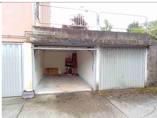
Veduta autorimessa (fg 20 part 895 sub 16)
