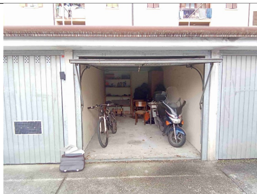
Veduta autorimessa (fg 20 part 895 sub 49)
