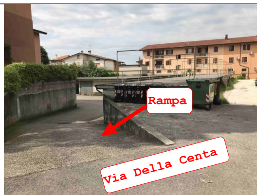
Veduta rampa di accesso da via Della Centa
