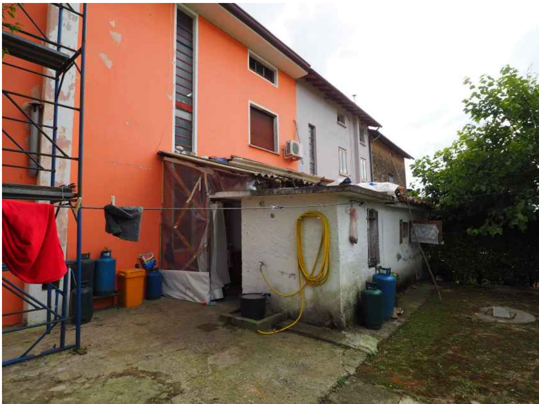
Azzano Decimo, via Pustotti n. 8 - Il prospetto nord della casa indipendente e la corte esterna.
