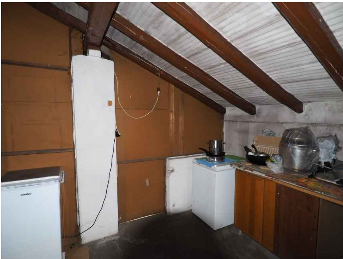
Azzano Decimo, via Pustotti n. 8, P. II. – La soffitta con destinazione catastale granaio.
