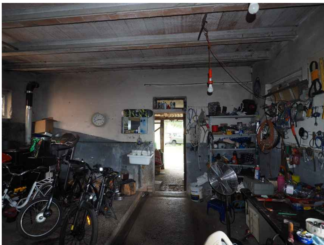
Azzano Decimo, via Pustotti n. 8 – Il locale ex stalla.
