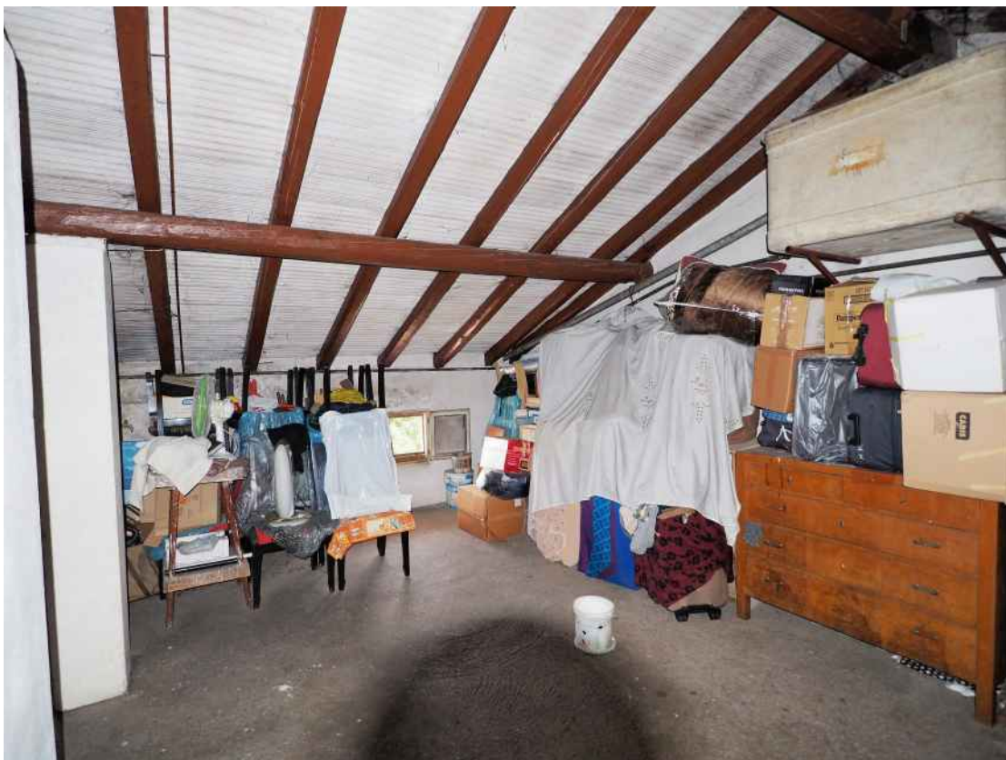
Azzano Decimo, via Pustotti n. 8, P. II. – La soffitta.
