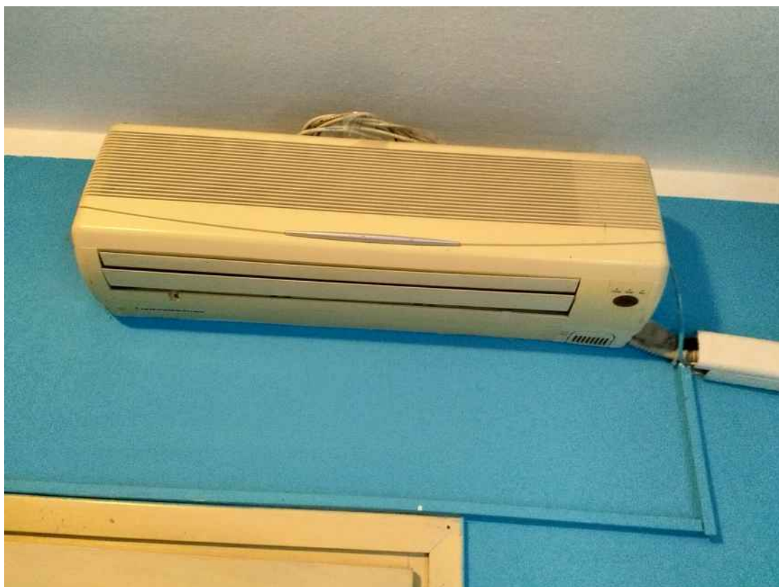
Azzano Decimo, via Pustotti n. 8 – Sopra particolare della cucina a legna - gas, sotto il climatizzatore monosplit.
