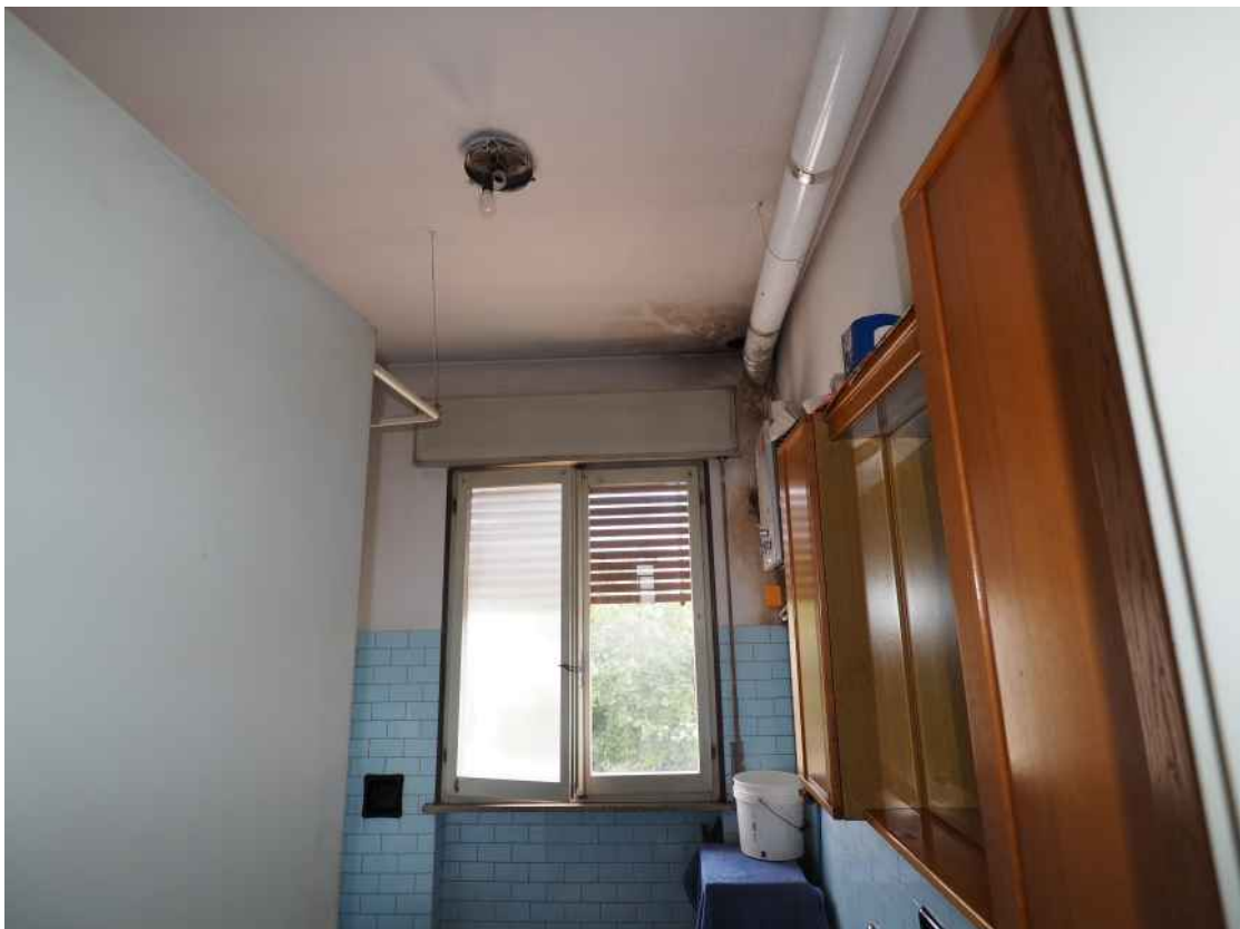
Azzano Decimo, via Pustotti n. 8 – Particolare degli infissi.
