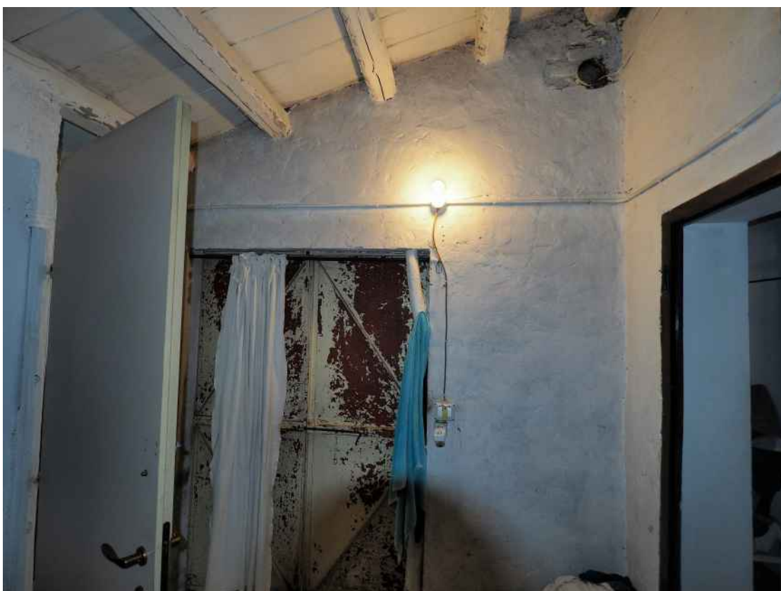
Azzano Decimo, via Pustotti n. 8, P.T. – Il locale cantina (trasformato in parte in antibagno).
