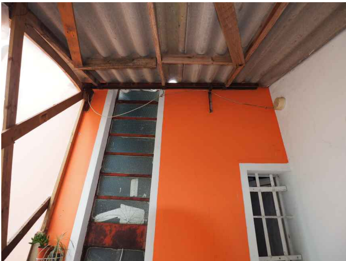
Azzano Decimo, via Pustotti n. 8 – Evidenziato in rosso il ripostiglio esterno abusivo e la copertura in Eternit.
