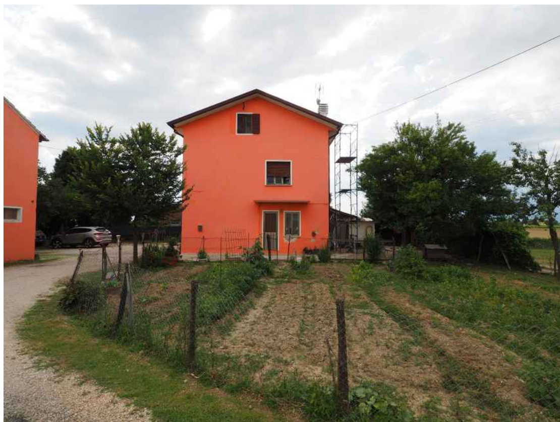
Azzano Decimo, via Pustotti n. 8 - Il prospetto est della casa indipendente e la corte esterna.
