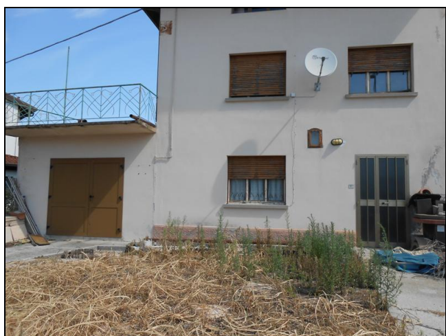
3) Portone ingresso accessori da scoperto
