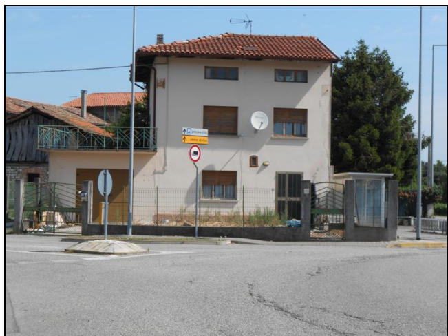
1) Veduta del fabbricato dalla strada
