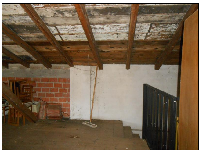
9) Vedute scala interna
