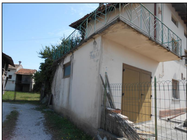
25) Particolari del fronte ovest
