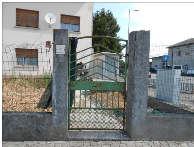
2) Cancello di ingresso all'abitazione
