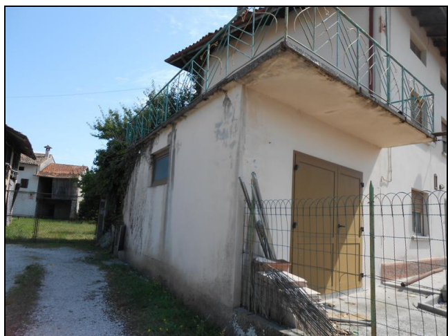
51) Vedute terrazzo da scoperto
