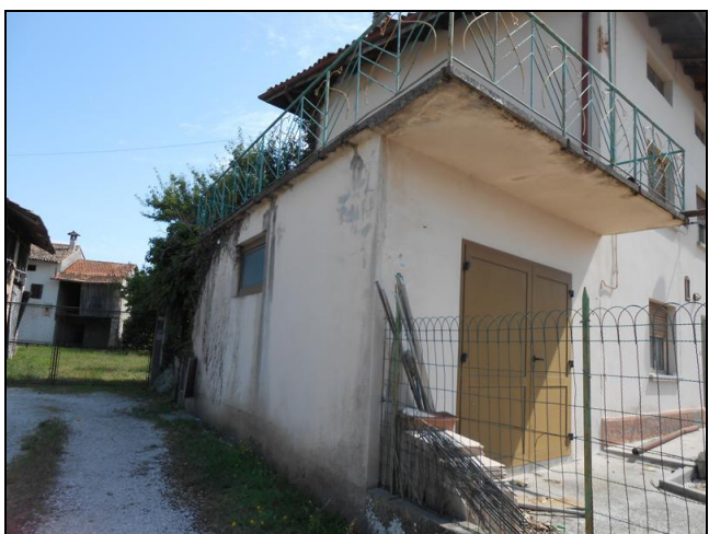
6) Veduta angolo sud-ovest
