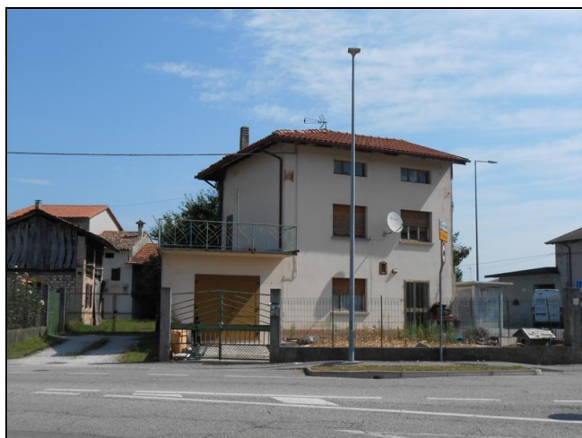
1) Veduta del fabbricato dalla strada
