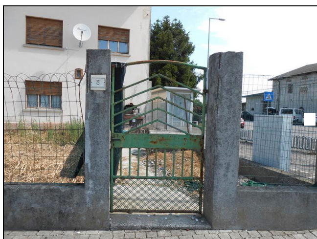
9) Cannello di ingresso al civico n. 3
