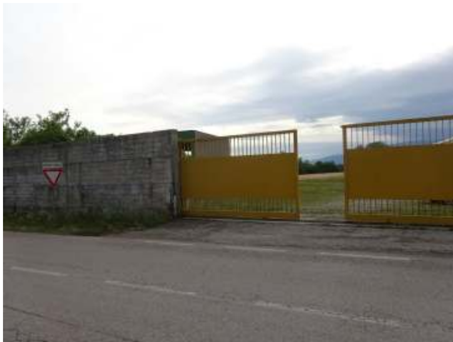
ACCESSO ALL'IMMOBILE ATTRAVERSO ALTRA PROPRIETA'
