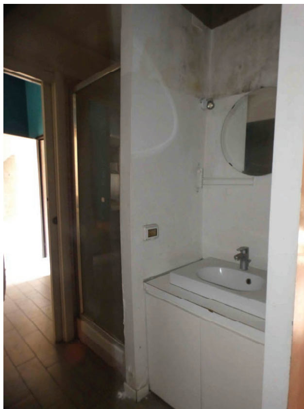
Foto 11. Corridoio 1 con doccia e lavabo
