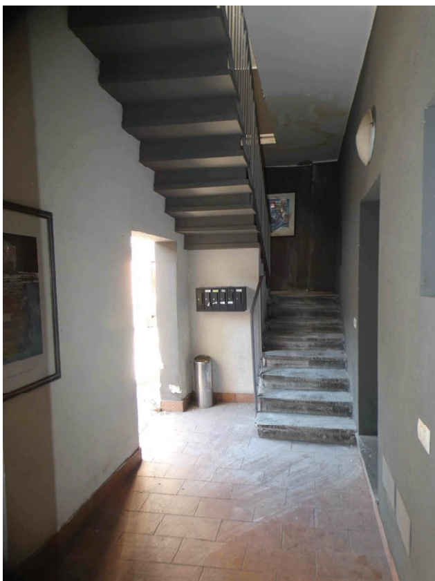
Foto 6. Vano scale comune (mapp.99 sub.710)
