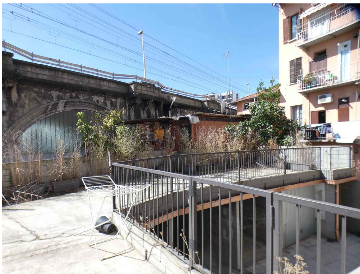
Foto 22. Copertura box adibita a terrazzo
