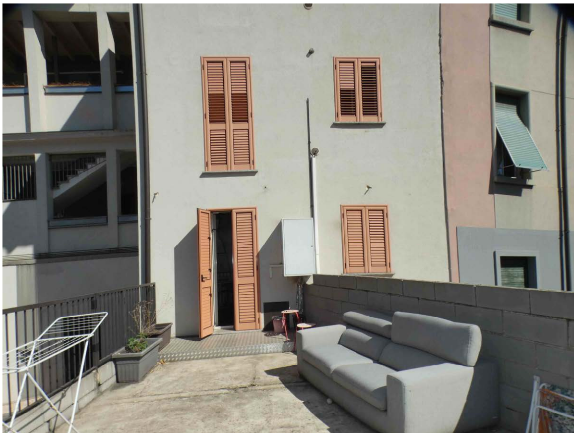
Foto 23. Copertura box adibita a terrazzo
