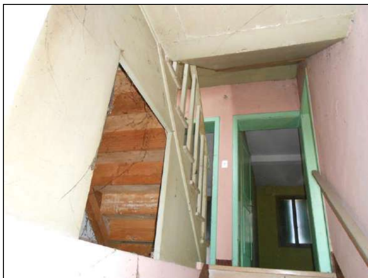
11) Smonto della scala al piano primo
