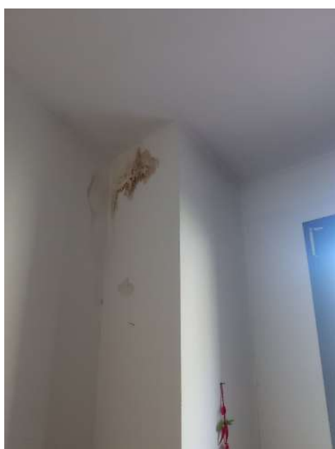
Foto n. 43: dettaglio dell'infiltrazione dalla canna fumaria.
