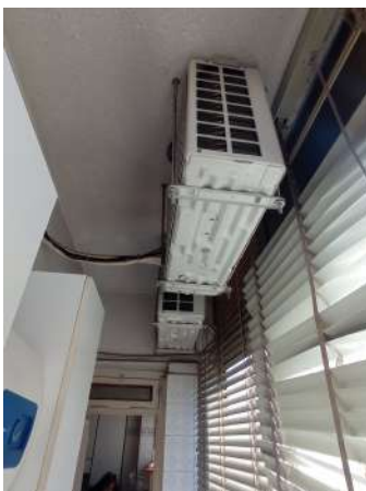
Foto n. 35-36: dettaglio delle unità esterne dei condizionatori e dello scaldacqua posto sopra il livello.
